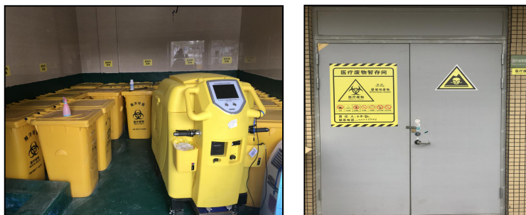
图 4-5 医疗垃圾暂存间
